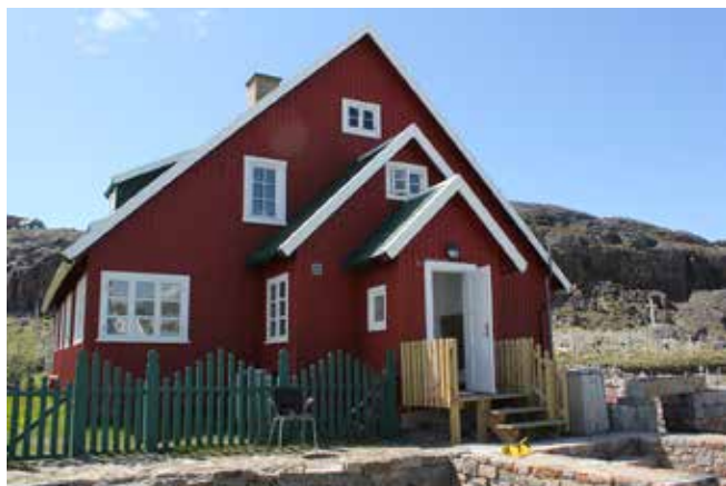
Det nyistandsatte B5, som er job- og vejledningscenter i Qaqortoq.
