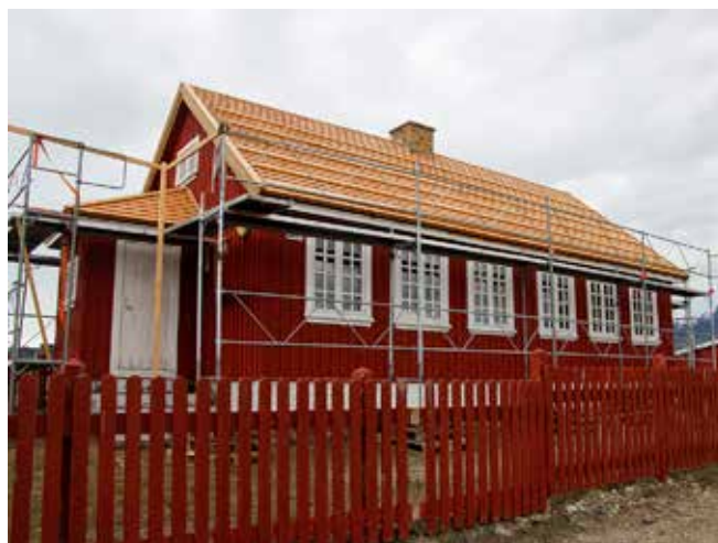
Renovering af taget til B-84, Piareersarfiks kontor i Narsaq.
